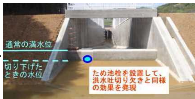
水位低下の防災対策を実施
