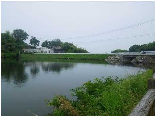
13,200 m 3 の雨水貯留容量を確保する 「 よりあひいけ 寄合池」(淡路市山田)
