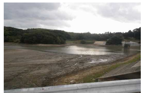
台風前に落水した状態のため池 (H26.10 淡路市志筑 黒田池)
