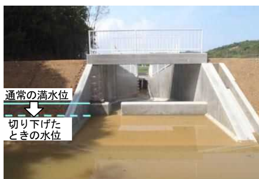
洪水吐の一部切り下げによる整備 （南あわじ市 高坂池）
