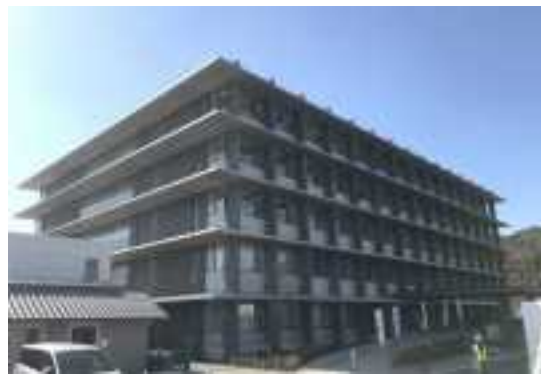
図 48 洲本総合庁舎の建物嵩上げ
