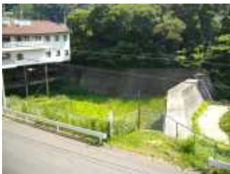
淡路島シーサイド開発調整池（淡路市）
