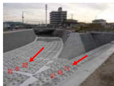
志筑川放水路と 宝珠川の合流部
