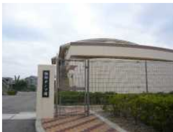
物部ポンプ場（洲本市）
