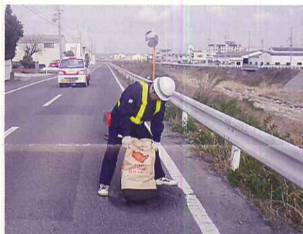
道路の軽微な損傷は、常温合材(アスファルト)を仮埋めするなど、応急処置を施します。
