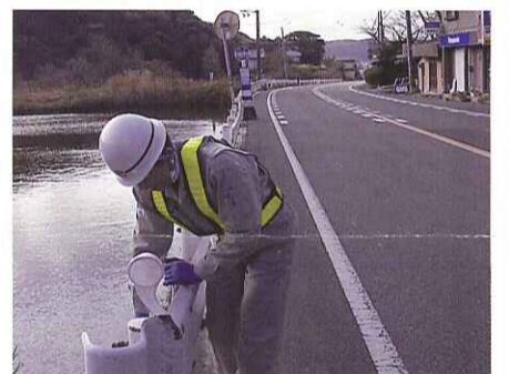
経年劣化によって機能が低下したデリネーター(視線誘導標)を交換します。
