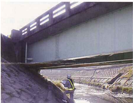
橋梁の損傷及び変状を早期に発見するため、定期点検を行っています。
