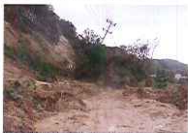
▲土砂で埋もれた県道31号
