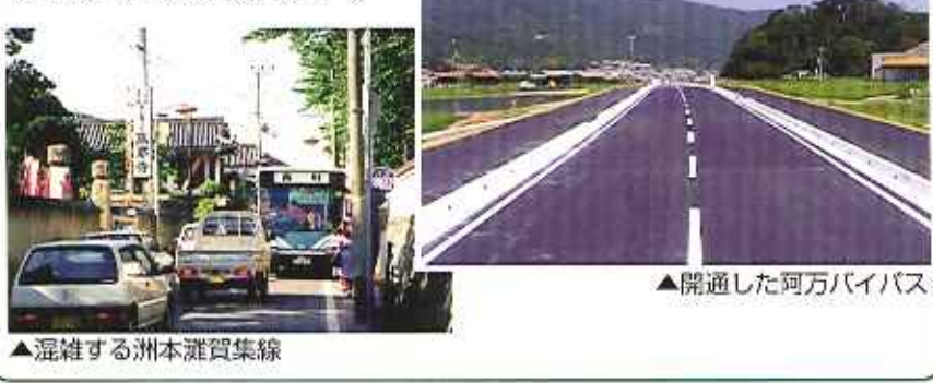
▲混雑する洲本灘賀集線 ▲開通した阿万バイパス
