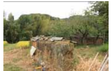
古民家の土塀
