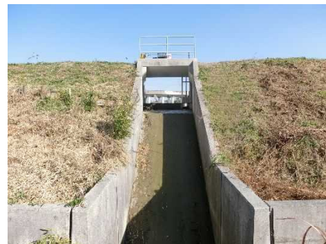
洪水吐(下流側)
