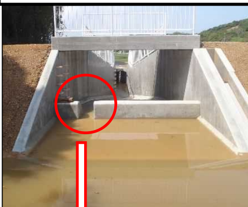
【南あわじ市 洪水吐越流堰の切欠き】
