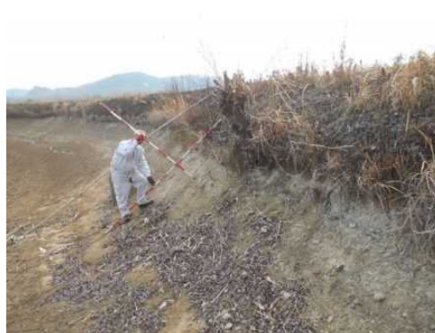
堤体の浸食状況等の点検
