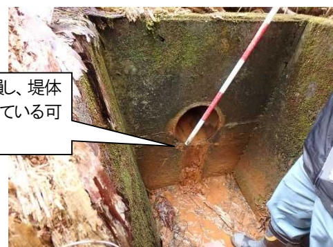
底樋出口(堤体下流)
