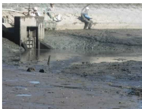
泥土除去後の状況(かいぼり実施後)
