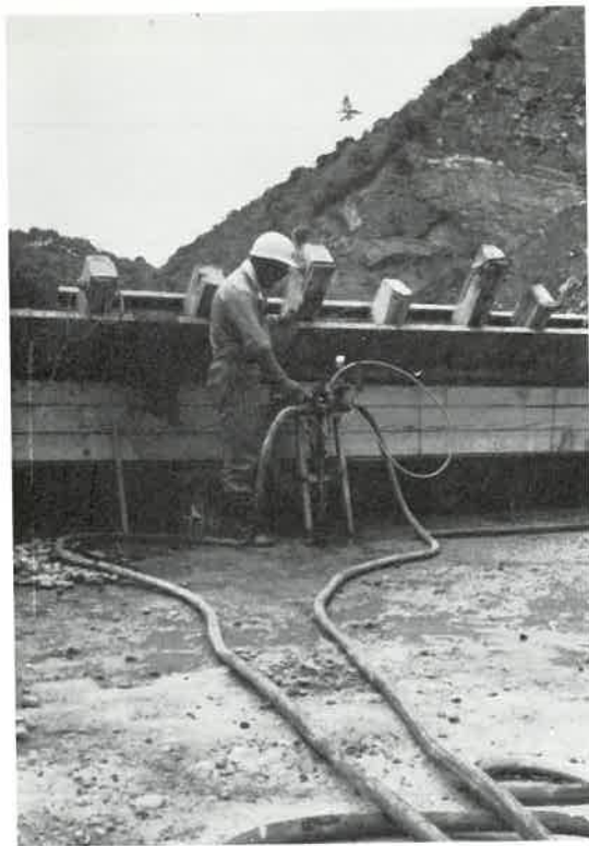
コンソリデーション グラウト工施工状況
