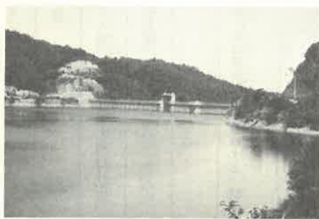
鮎屋川ダム全景
